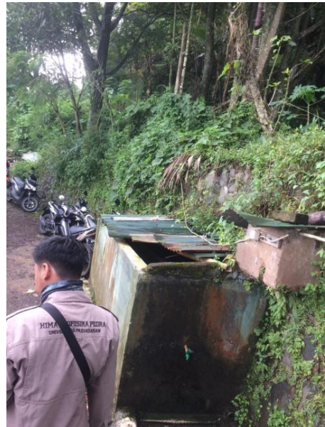
Penampungan air (1) menampung air dari sumur PNPB dan langsung dialirkan ke penampungan (2)
