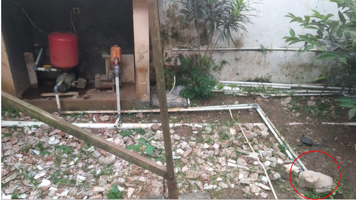
Gambar 15. Sumur bor dengan kedalam 12 meter dan pompa airnya
