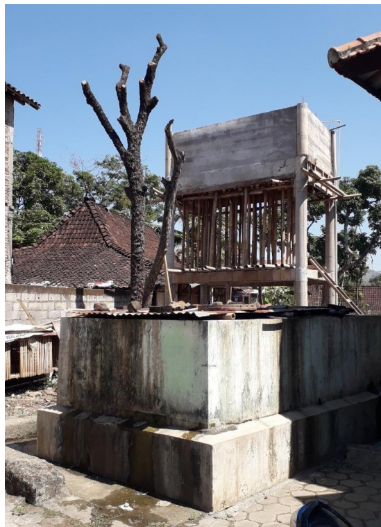
Foto salah sumur gali yang digunakan masjid Baitul Muttaqin (kedalaman 20 m)
